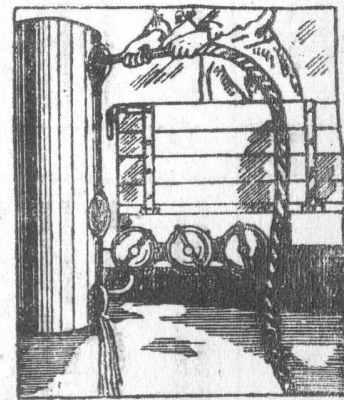
Рис. 23. Промывка колец Рашига в вертикальном очистителе.
